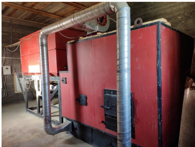
Алтайский край Первомайский район (500кВт на опилках и стружке) производится монтаж под ключ + монтаж сушильной камеры КСС-50
