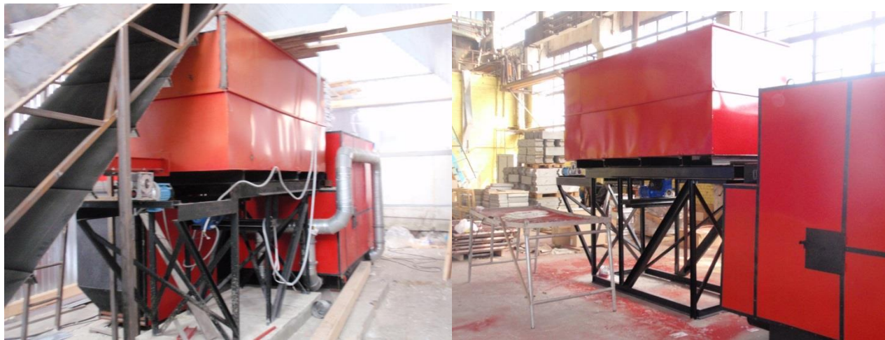
Система топливоподачи с оперативным бункером V=3м3
