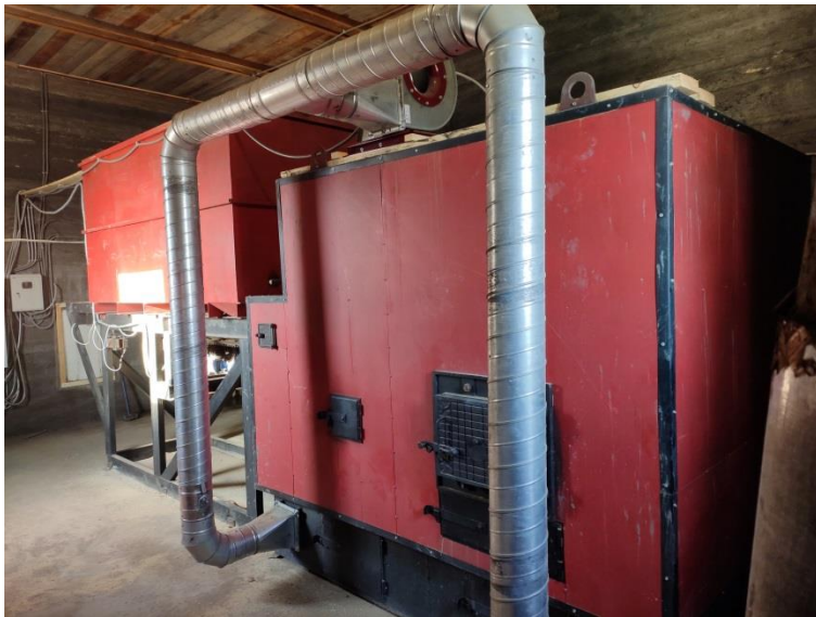
Алтайский край Первомайский район с.Зудилово (Сибирский барс) (500кВт на опилках и стружке) производится монтаж под ключ + монтаж сушильной камеры КСС-50
